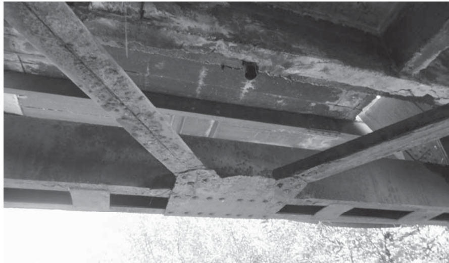
Рис. 2. Значна корозія балкової клітки і з'єднань
